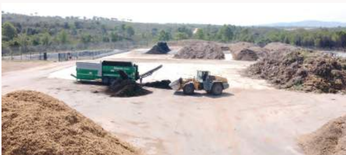
Plateforme de compostage du SMIDDEV à Puget-sur-Argens
