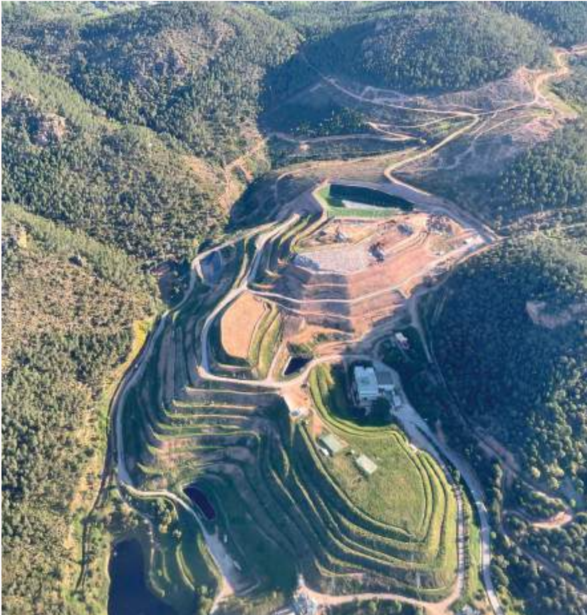
Vue aérienne de l'ISDND – Mai 2021
