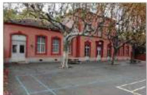
L'école Lucie-Aubrac va bénéficier de travaux de rénovation. (Photo J.-P. P.)
